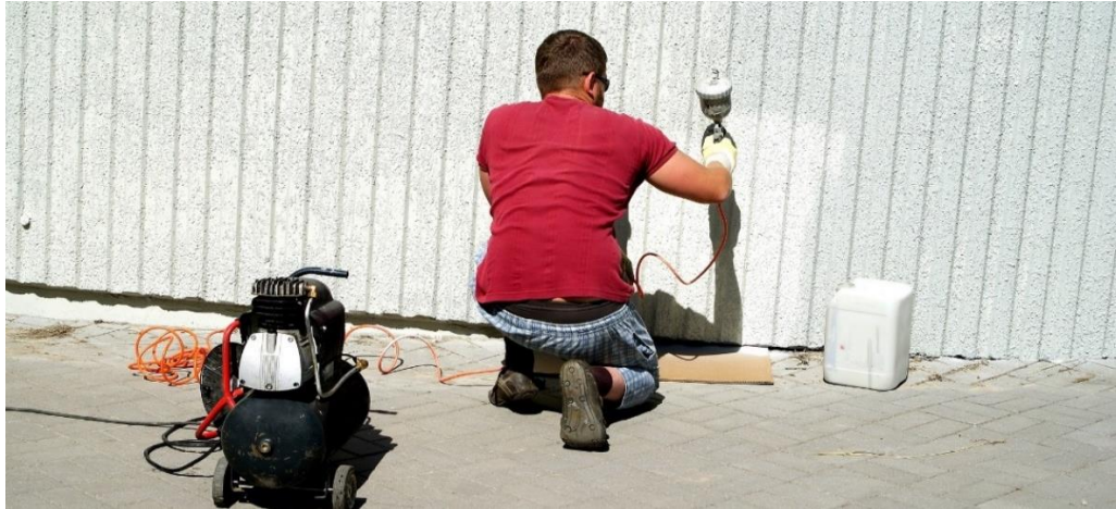
Figura 3. Aplicación de pintura sobre superficie.
