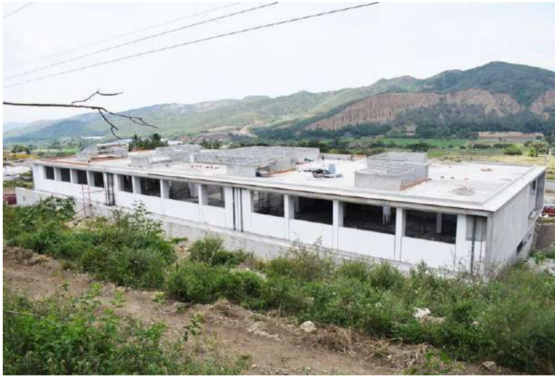
Vista de la infraestructura en construcción
