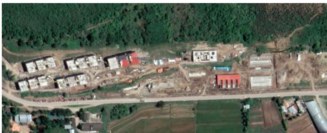
Vista aérea de la infraestructura en construcción
