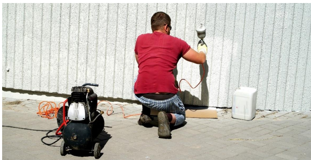
Figura 3. Aplicación de pintura sobre superficie.
