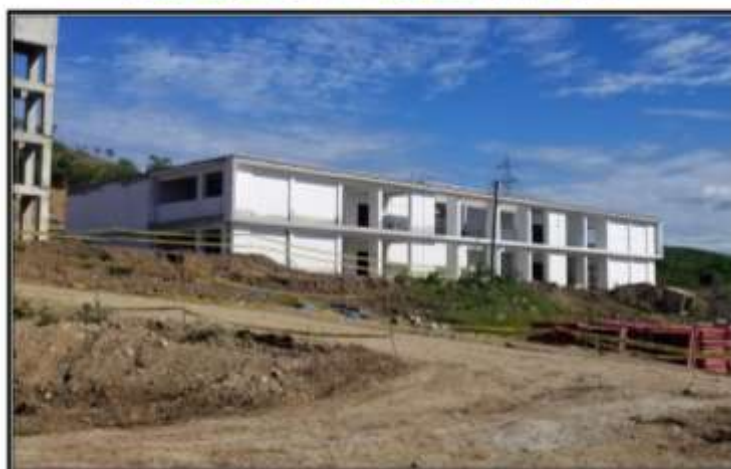
FOTO N° 26: VISTA DEL MÓDULO DE BIBLIOTECA
