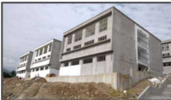
FOTO N° 17: VISTA FRONTAL DE FACULTAD DE ING. MECÁNICA ELÉCTRICA
