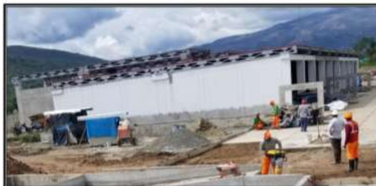
FOTO N° 32: VISTA DEL MÓDULO DE COMEDOR
