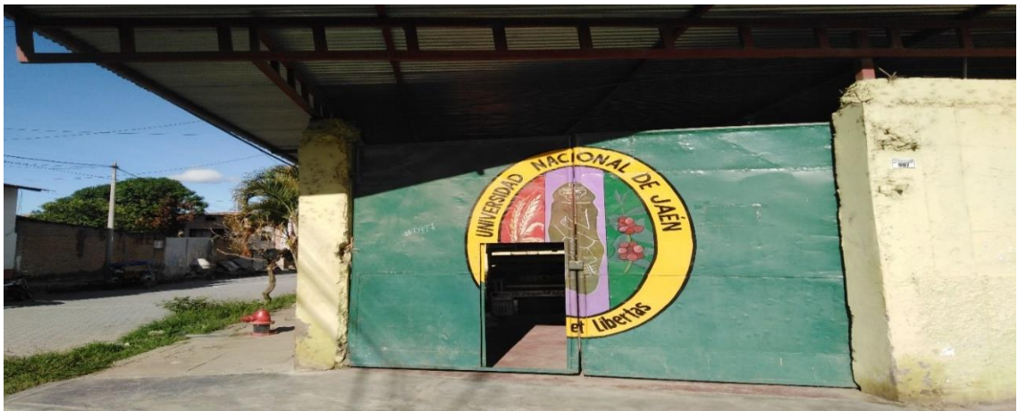
Fotografía 19. Fachada presenta deterioro
