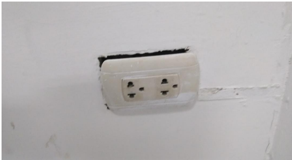
Fotografía 02. Tomacorrientes expuestos
