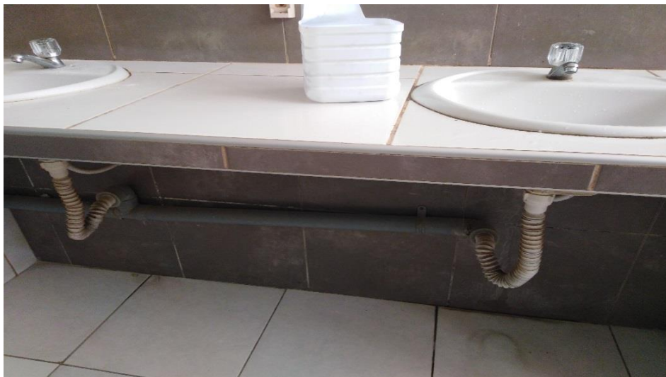
Fotografía 05. Tubos de abasto de lavatorio
