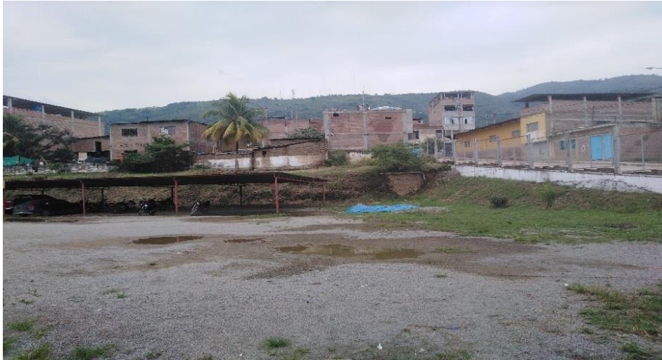
Fotografía 12. Acumulación de aguas pluviales.
