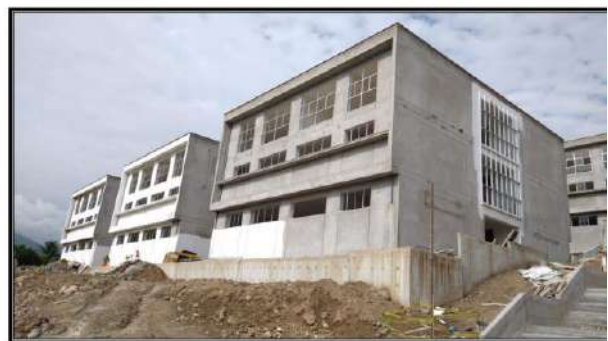
FOTO N° 17: VISTA FRONTAL DE FACULTAD DE ING. MECÁNICA ELÉCTRICA
