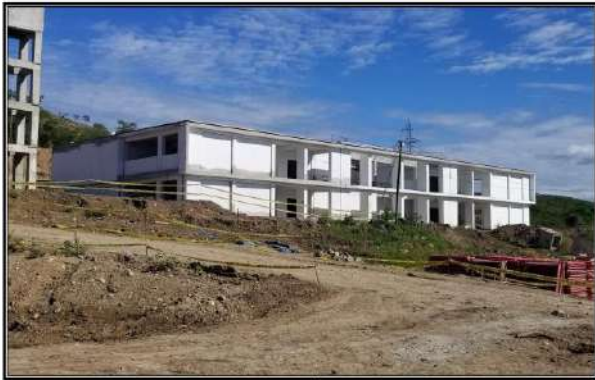
FOTO N° 26: VISTA DEL MÓDULO DE BIBLIOTECA
