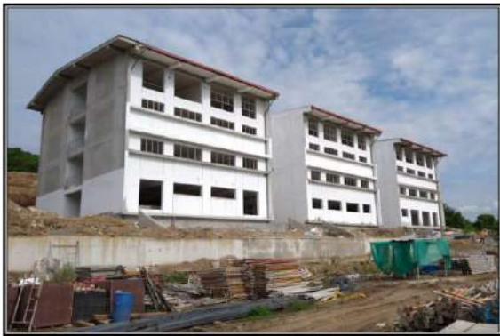
FOTO N° 1: VISTA FRONTAL DE FACHADA DE LA FACULTAD DE ING. CIVIL.
