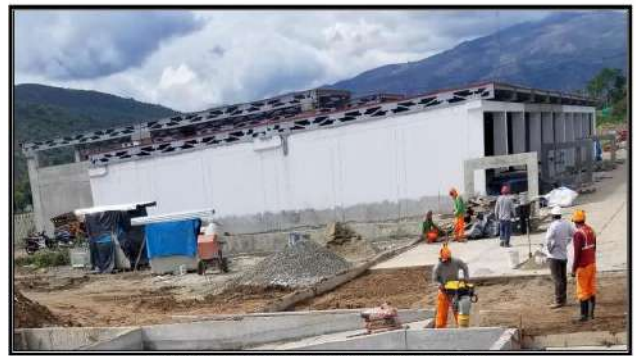
FOTO N° 32: VISTA DEL MÓDULO DE COMEDOR
