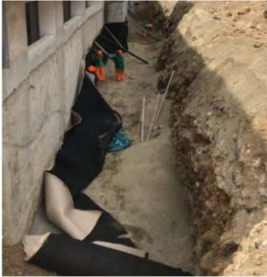
Vista Fotográfica de tendido de Geocompuesto para trabajos de sub drenaje
