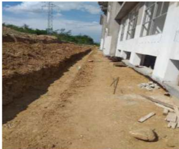
Vista Fotográfica de relleno con material granular y propio seleccionado en capas, para Sistema de Sub Drenaje
