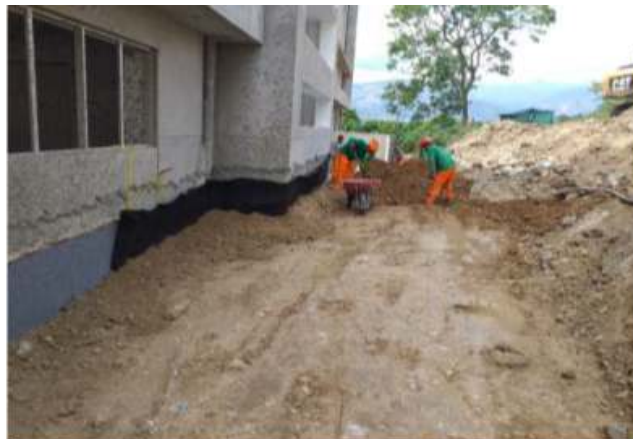
Vista Fotográfica de trabajos de compactación de material de relleno en sub drenaje
