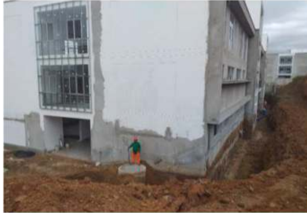
Vista Fotográfica de tendido de geo compuesto y tubería en trabajos de sub drenaje
