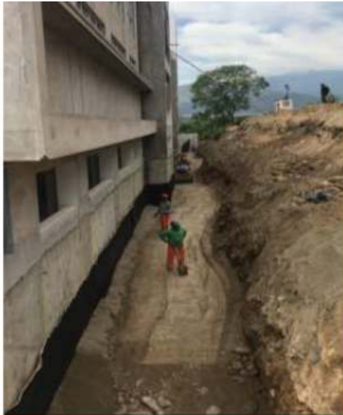
Vista Fotográfica de compactación de material de relleno en trabajos de sub dren
