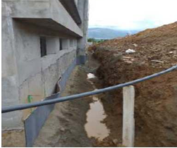
Vista Fotográfica de trabajos en sub dren
